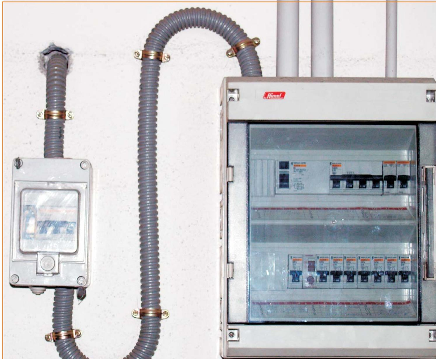
*Figura 3.49. Montaje de un cuadro. Se saca la chapa, se montan las canaletas y los perfiles.*
